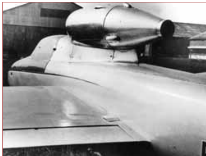
Cyclope I F-WCZO, à gauche avec avec le capotage réacteur démonté. (coll. SHLADA)
