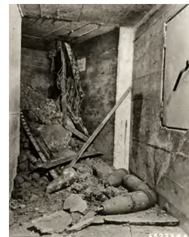
La voûte d'une salle de stockage s'est effondrée sous l'intensité des bombardements. (NA)
