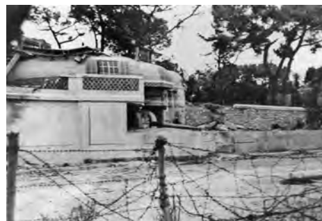
Bunker typique de la côte sud (ici à Cannes) abritant et camouflant avec beaucoup de soin une pièce de 75 mm d'origine française munie de son masque d'origine. (Photo DR)
